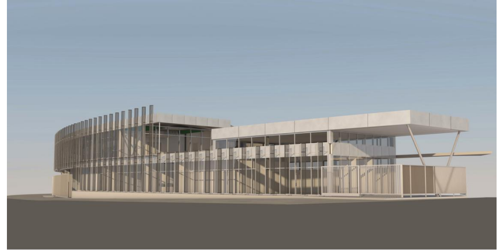
La salle d'activités, depuis la rue Edmond GOMBEAUX
